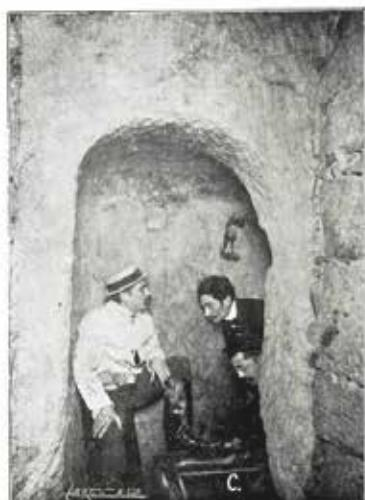
Fig. n.º 58 — Manancial da Cavaca. Ângulo recto onde a mina começou a ser aberta em picarra dura e a abóbada termina. C., Calcira.
