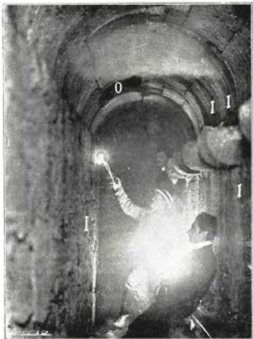
Fig. n.º 59 — Manancial da Cavaca. O oculo proximo do cotovello em que as infiltrações são abundantíssimas correspondendo exteriormente ao ponto representado na figura seguinte.
