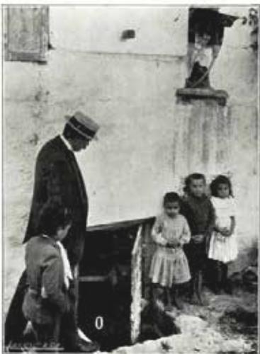
Fig. n.º 60 — Costas da fonte da rua Firmeza. O., indica um cano onde se juntam várias águas imundas e que coincide justamente com o orifício de abobada onde se vêem abundantes infiltrações.
