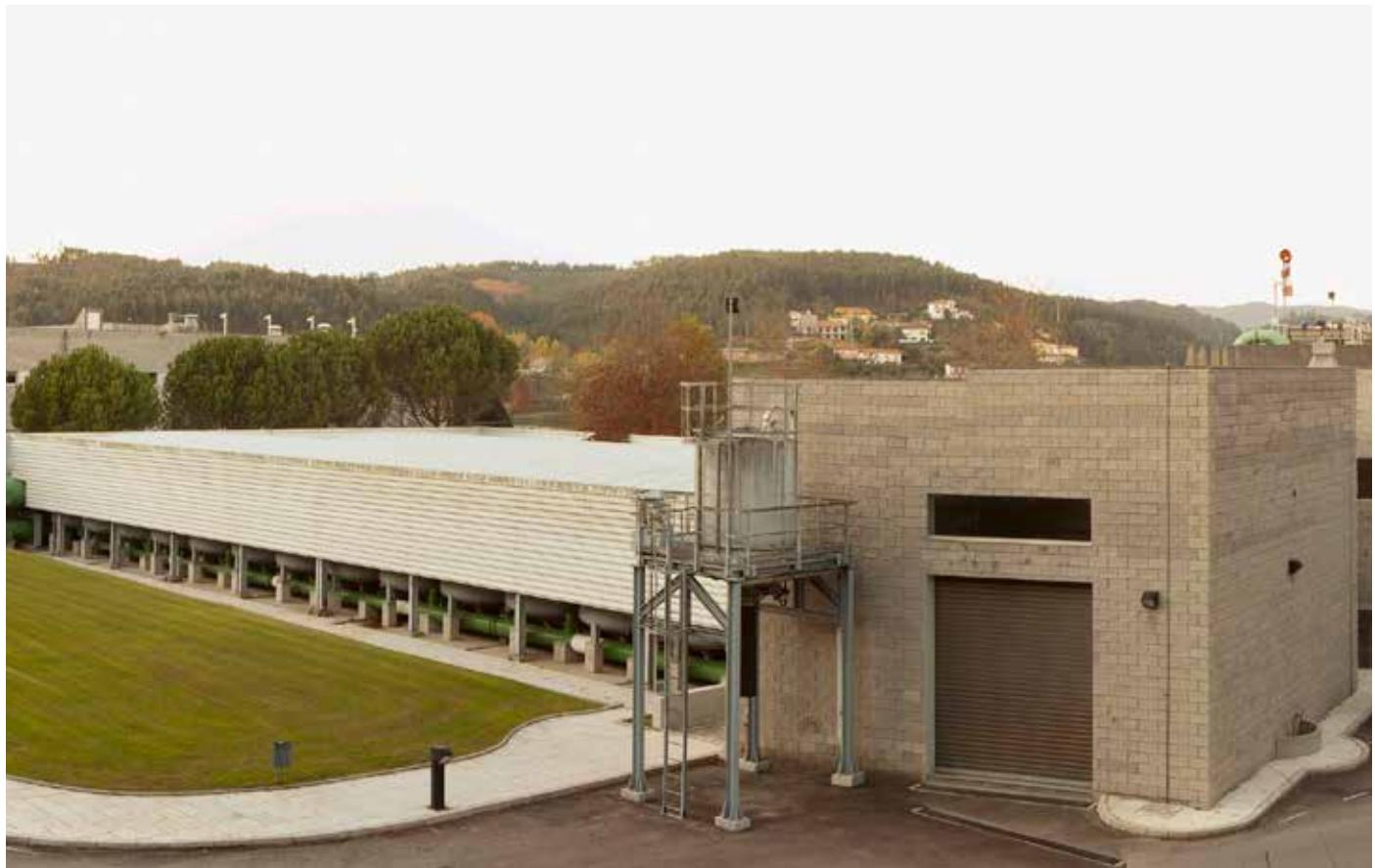
1. Captação - A água é captada na albufeira de Crestuma-Lever por grupos de elevação submersíveis e encaminhada para um reservatório de água bruta. A cota da superfície da água neste reservatório é suficiente para facilitar substancialmente o escoamento de água até ao final do processo (aproveitamento gravítico).
