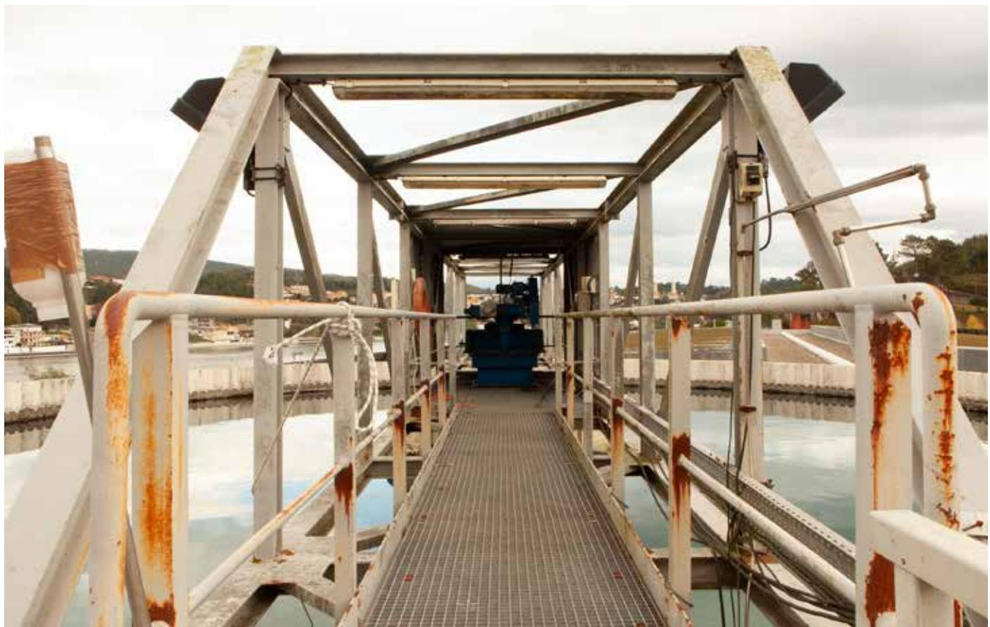
4. Tratamento de Lamas - As águas de lavagem dos filtros e as lamas recolhidas à superfície dos tanques são dirigidas para a Unidade de Tratamento de Lamas, onde são desidratadas.
